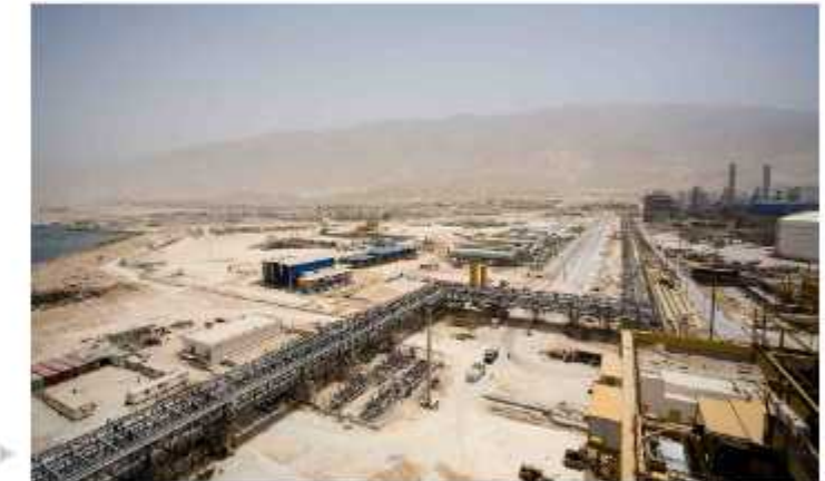
عنوان پروژه: اتصال فاز ۱ و ۲ کارفرما: صنایع ملی پتروشیمی - پتروشیمی دماوند محل پروژه: عسلویه
